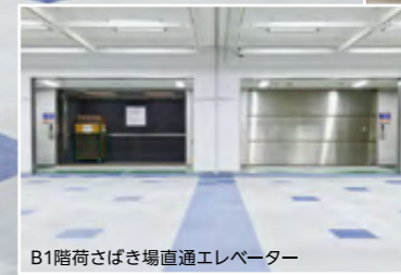
B1階荷さばき場直通エレベーター
